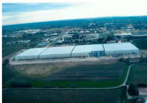
Se trata de construcciones de gran simplicidad en lo técnico y formal, y de reducido costo. Sus estructuras son en general de reticulado metálicos simples en columnas, o de madera, o de hormigón armado.
