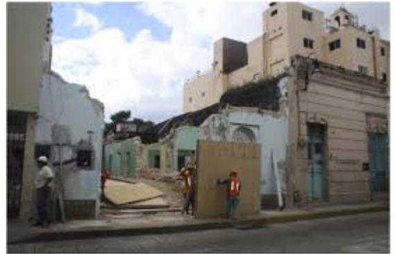
Vigas de madera, pisos de parquet y entablonados, carpinterías, artefactos, chapas para techos, el plomo de cañerías, rejas, barandas de escaleras y balcones, tejas y pizarras para techos, etc., son ejemplos de materiales de demolición que se comercializan posteriormente en corralones, cada uno por separado y generalmente a valores monetarios que no tenían o que no se les asignaba cuando estaban en la edificación original, y que ahora implican una erogación de mayor monto.
